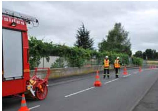
► Le balisage sera positionné du point le plus éloigné en remontant vers le chantier, les équipiers se positionneront face au danger principal, à l'intérieur de la zone de protection en déposant un cône tout les 10 mètres environ
