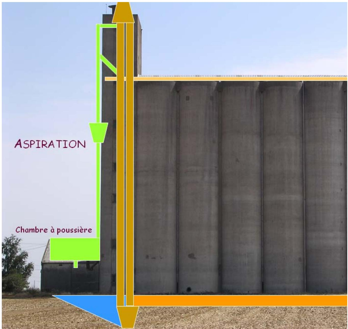
Les poussières sont particulièrement présentes dans la tour de manutention et plus précisément au sein de l'élévateur. Ces poussières sont aspirées par un dispositif à demeure pour être collectées au sein d'une chambre à poussière.
