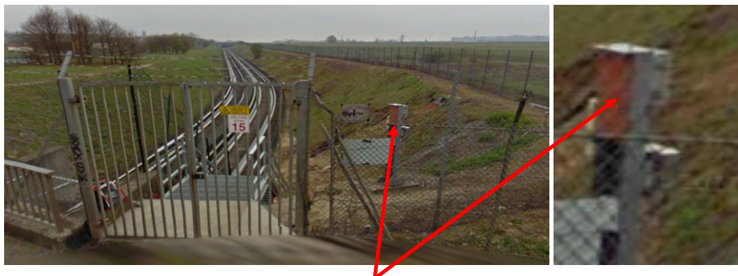
Borne d'appel téléphonique Rupteur d'Urgence RU (Coupure électrique)
