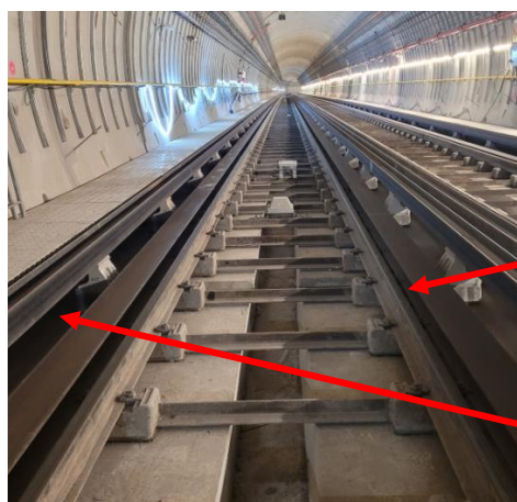
Barre de traction (750 volts en continu)
