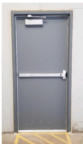
Porte équipée d'un ferme-porte à l'entrée d'un local à risques particuliers
