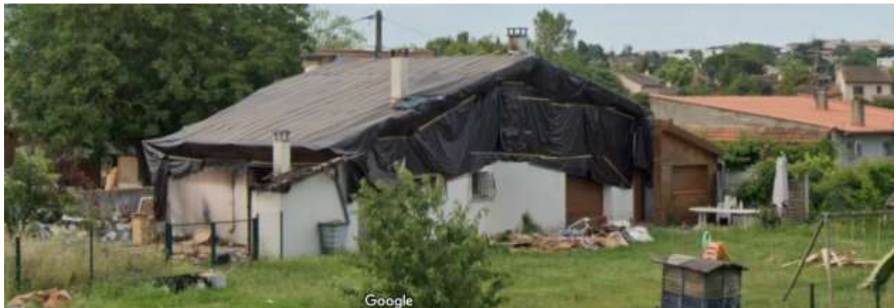
Vue de la maison après bâchage de l'intégralité de la toiture
